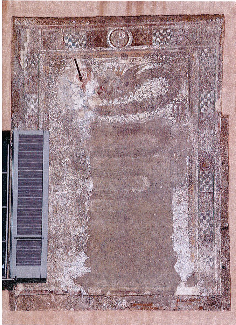
Prima del restauro
