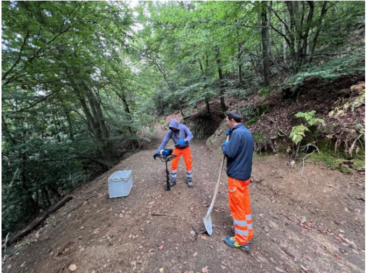
Fig. 7: operazioni di trivellazione della sovrastruttura della strada forestale per la raccolta dei tre campioni.
