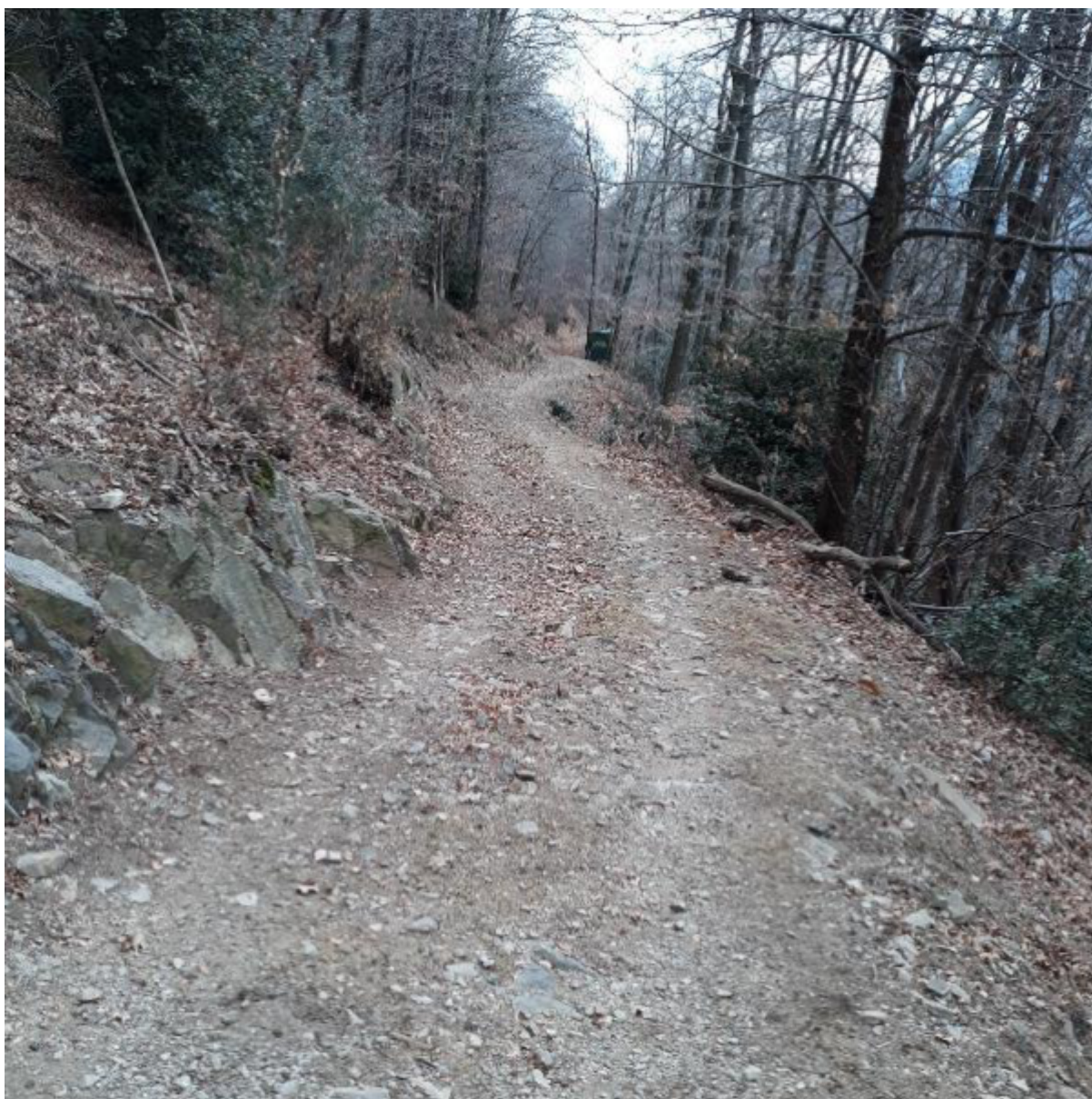
Fig. 3: situazione attuale pista, tratto in corrispondenza di una zona di ruscellamento.
