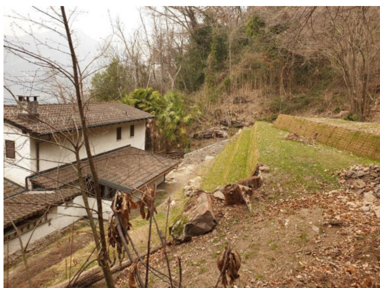
Figura 17: Particolare, muro di contenimento in terra armata (agg. giu. 2025) – ZONA 5.
