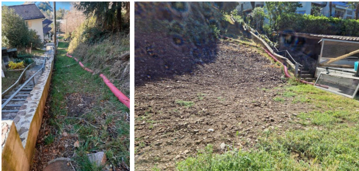
Figura 18: Particolare, tubo corrugato smaltimento idrico (agg. giu. 2025) – ZONA 5.
