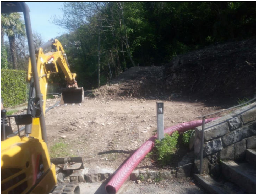
Figura 5: fossa A. Situazione del terreno prima dello scavo della fossa.
