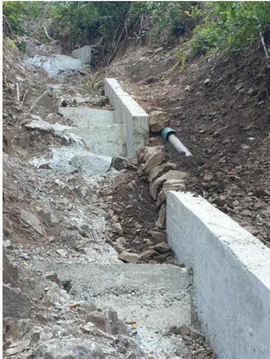
Figura 23: ZONA 3, salti di fondo esistenti e rinforzo sponda (estratta dal piano allegato).
