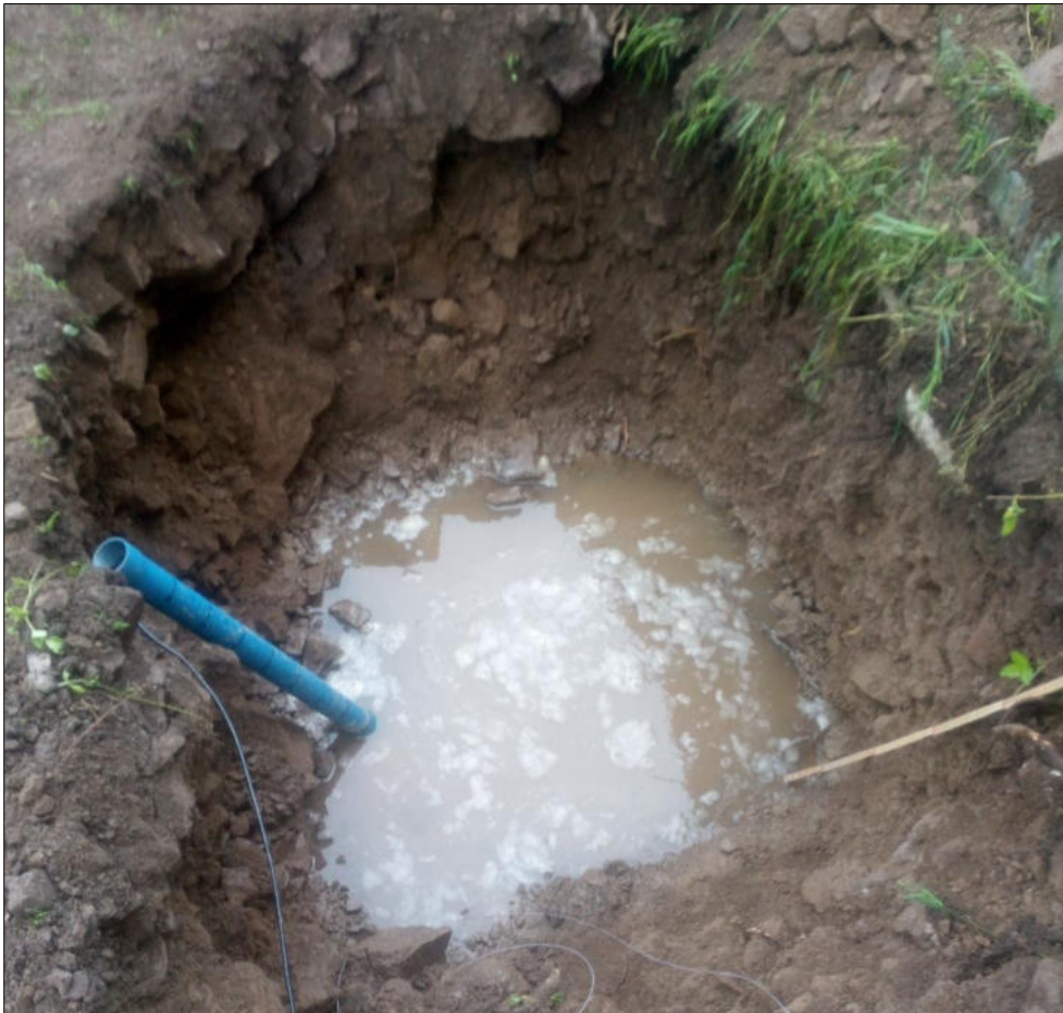
Figura 7: fossa B durante la prova di infiltrazione.
