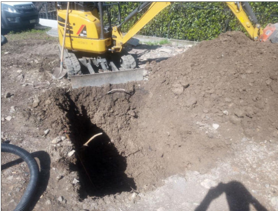
Figura 6: fossa A prima dell'inizio della prova di infiltrazione.
