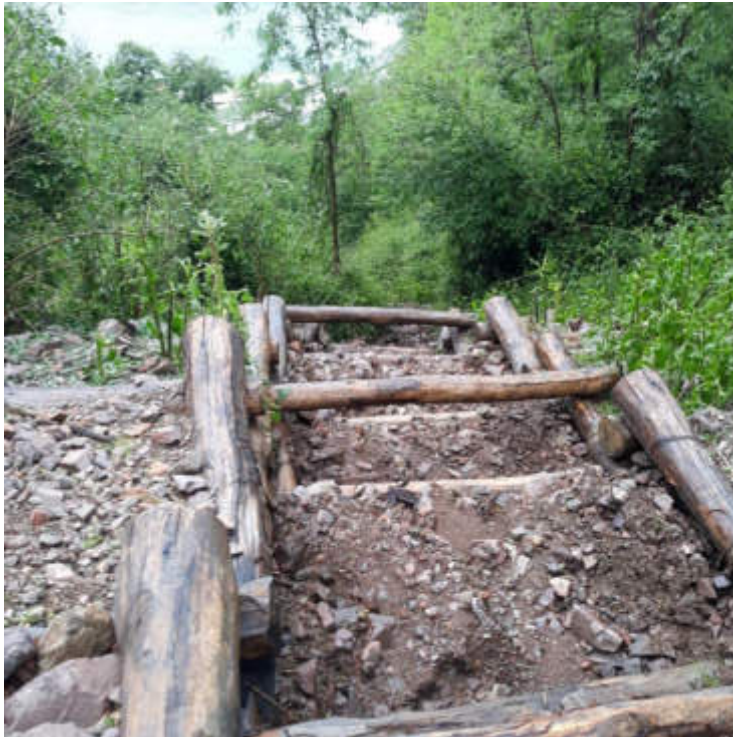
Figura 13: Cassoni di stabilizzazione eseguiti nel 2022. Vista da monte.
