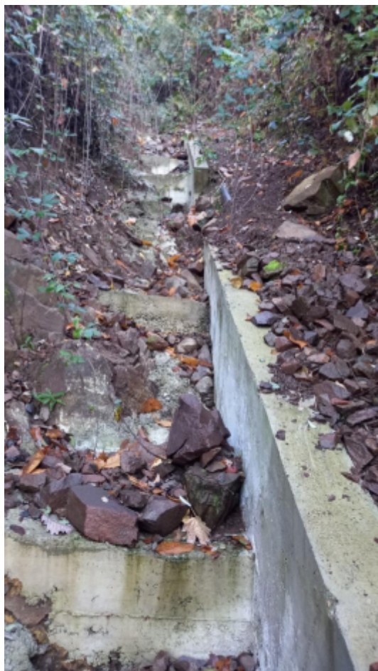
Figura 10: Settori di muro in CLS già realizzati.
