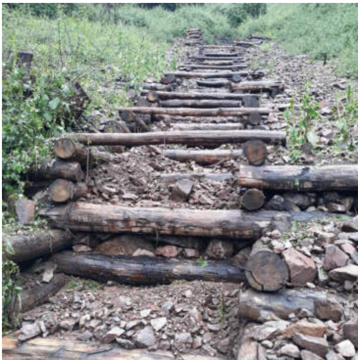
Figura 14: Cassoni di stabilizzazione eseguiti nel 2022. Vista da valle.
