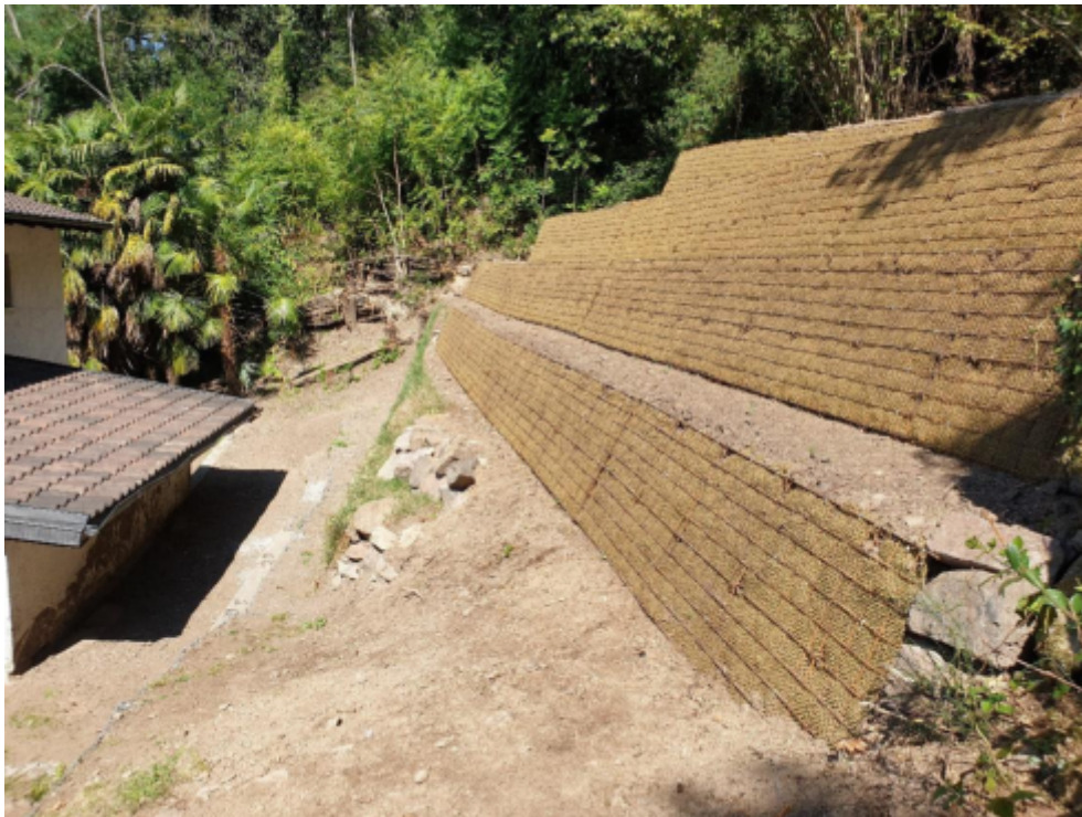
Figura 20: Vallo a monte dell'abitato di Bissone.
