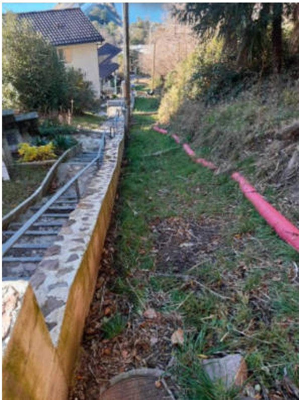
Figura 18: Drenaggio della briglia a valle.
