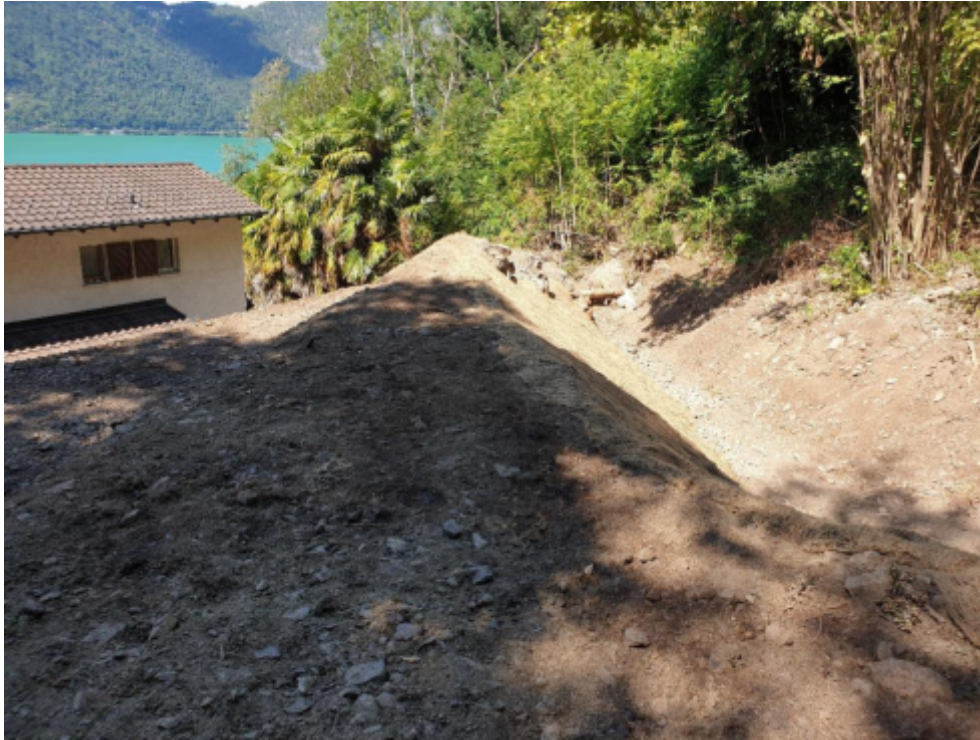
Figura 19: Vallo a monte dell'abitato di Bissone.
