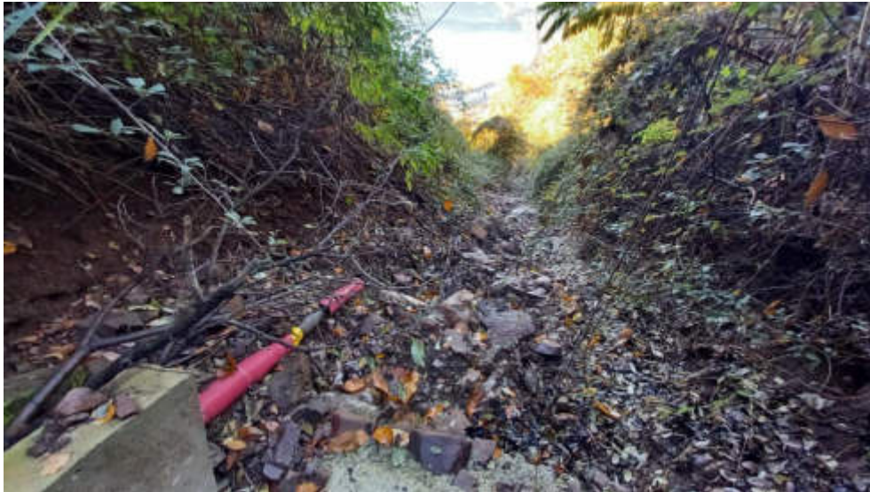
Figura 9: Vista della condotta AP esposta.
