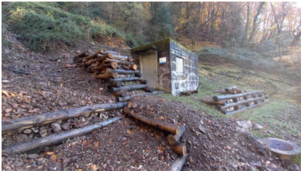
Figura 15: Stabilizzazione eseguita in corrispondenza del serbatoio a 430 m slm.
