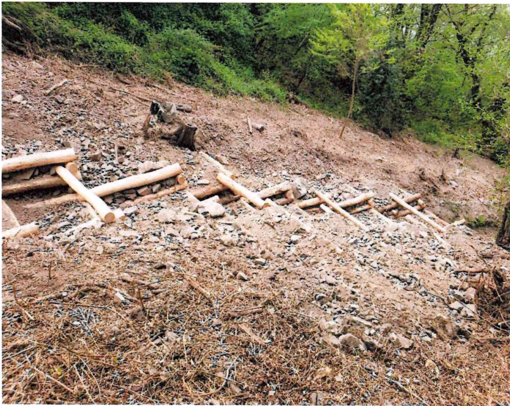
Immagine 2.4: caratteristiche della zona 4 (interventi di messa in sicurezza del 2022).
