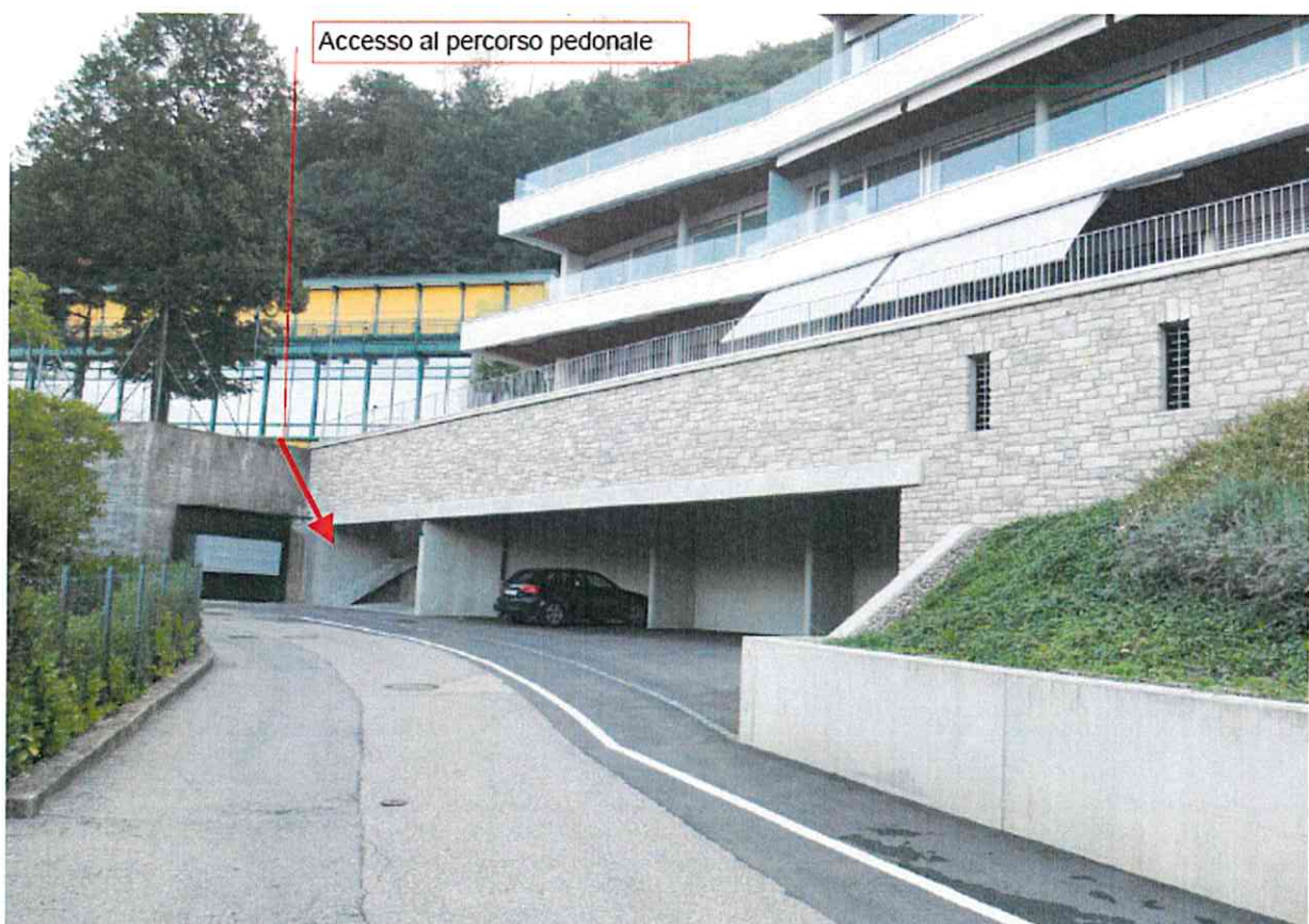
Figura 2: vista da via San Nicolao dei gradini di accesso pubblico del nuovo tratto di percorso pedonale
